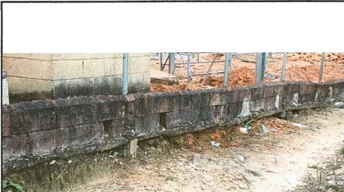
Foto 1: Reparación de muro perimetral por hundimiento
